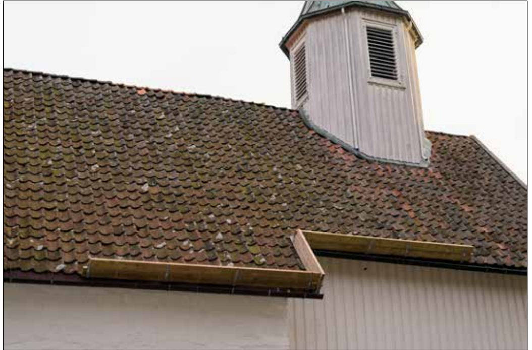
Kantbord er montert ved takskjegget som en midlertidig løsning for at folk ikke skal få takstein i hodet når de bruker sideinngangen.
